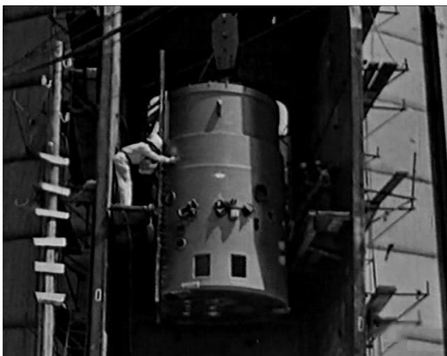
Posizionamento dello schermo termico del reattore Ispra-1
