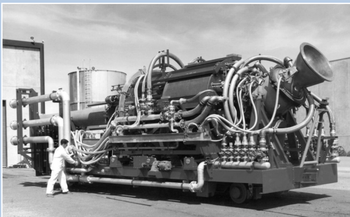
Prototipo di motore nucleare per la propulsione missilistica Tory-II A, sviluppato in USA negli Anni '60.
